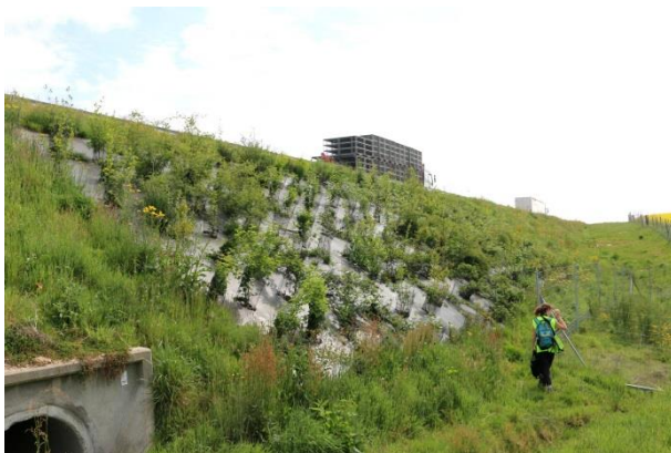
Fig. 6.45 – Talus planté dans la DVR de la RN 149/249 (Bretignolles, Deux-Sèvres) ©Héloïse Blanchard
