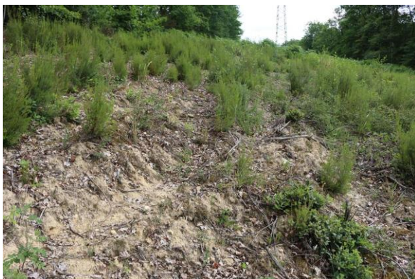
Fig. 6.16 – Vue du site D94_T3 ©Héloïse Blanchard
