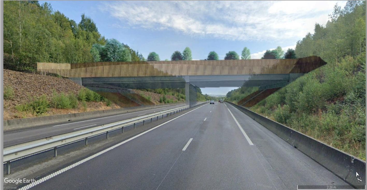
Remblais présents des deux côtés de l'autoroute
