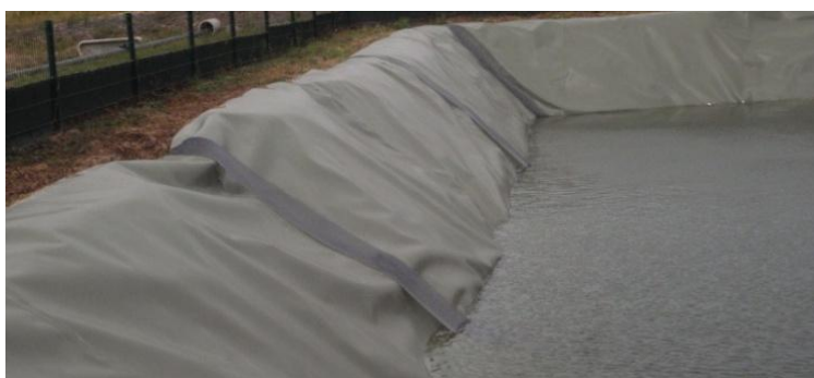
Figure 17 : Géomembrane permettant la sortie des amphibiens
