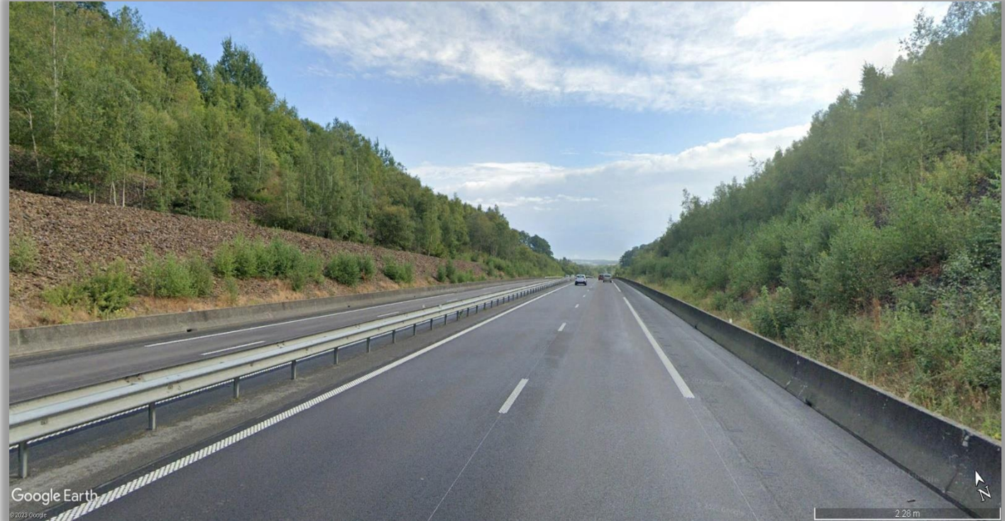
Remblais présents des deux côtés de l'autoroute
