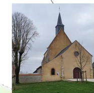
Restauration de l'église et de ses abords à Huêtère
