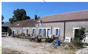
Réfection des enduits d'une grange à Bouilly-en-Gâtinais
