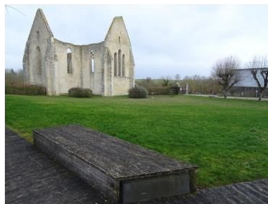
Aménagement de la place Saint-Lubin à Yèvre-le-Châtel
