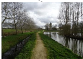
Réaménagement de la mare du Grand Marchais à Chevilly
