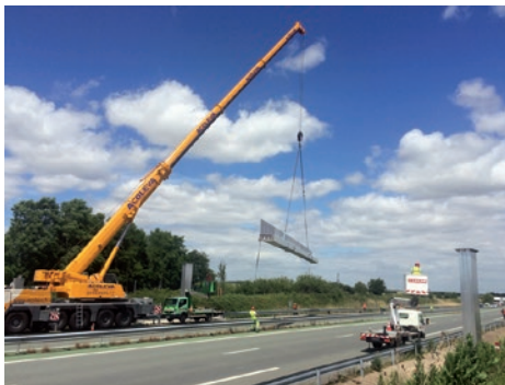
Levage portique A83. ©VINCI Autoroutes.
