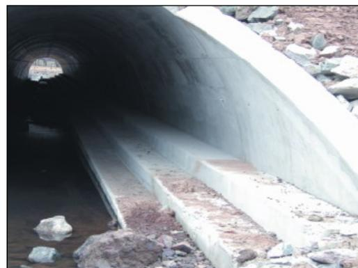
Fig 16 – Exemple d'ouvrage de transparence hydraulique pouvant être emprunté par les loutres. (Source : Biotope)
