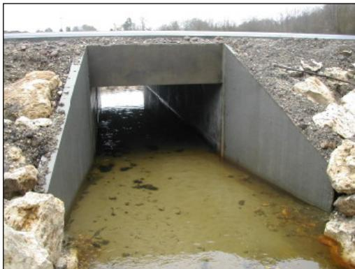
Fig 15 – Ouvrage de transparence hydraulique mise en place sur un tracé (Source : Biotope)
